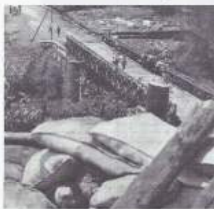
Een brug werd gelegd
