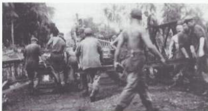
Hier wordt een Baileybrug gebouwd. Henk Pos loopt op de voorgrond met 2 verbindingsspennen in zijn hand.
