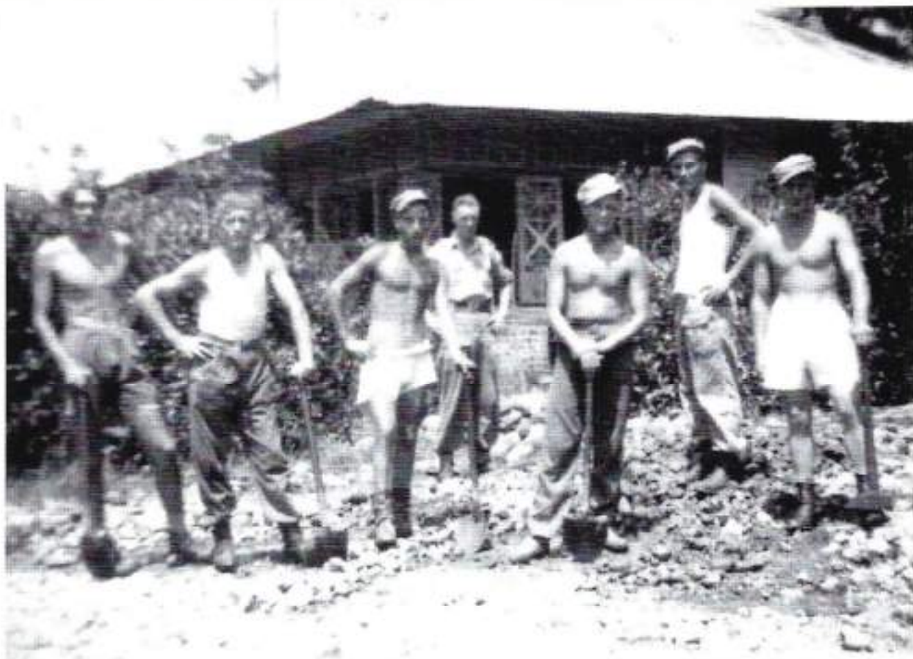
Het schoolgebouw 'Pro Juventute'. Als bouwvakkers aan de slag.
