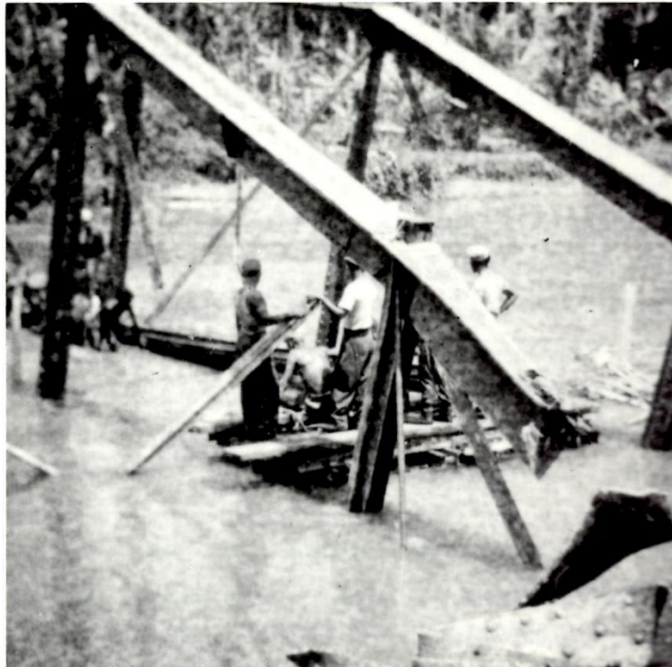
De Genie repareert de vernielde brug
